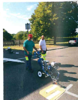
La commune s'est dotée d'une traceuse pour l'entretien de la signalisation horizontale.
