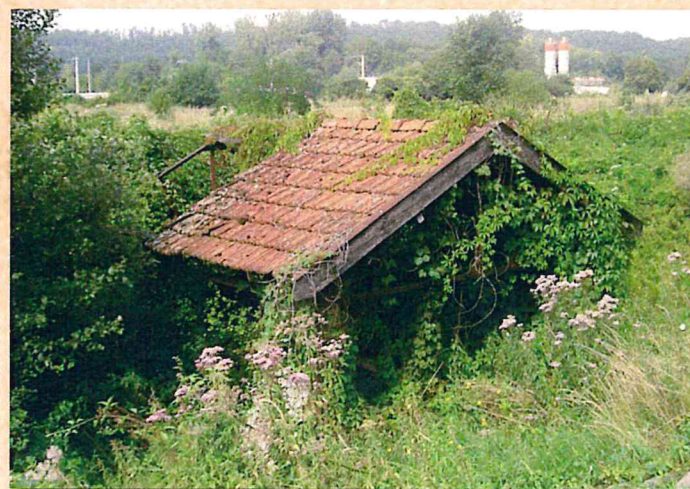
État en août 2004.
