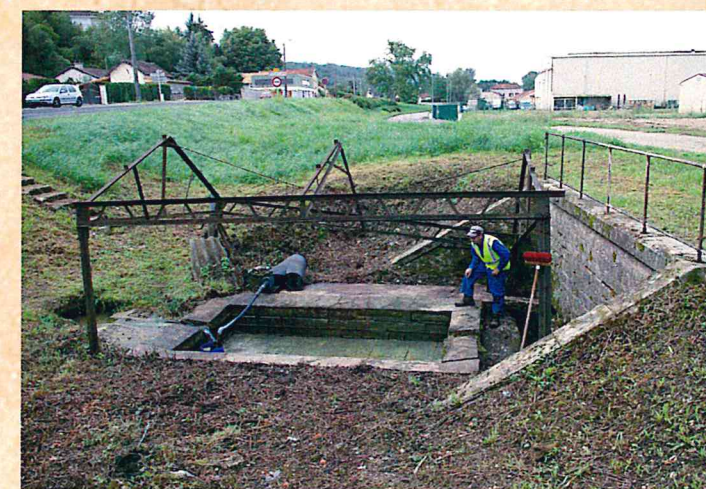
État en août 2014.
